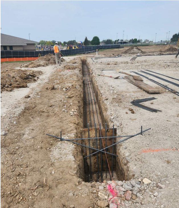
Entrenched rebar prior to foundation pour (complete).
